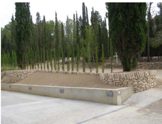
Muro de piedra seca
