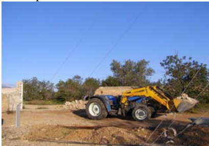
Obras de ampliación de la puerta de emergencias del Observatorio.
