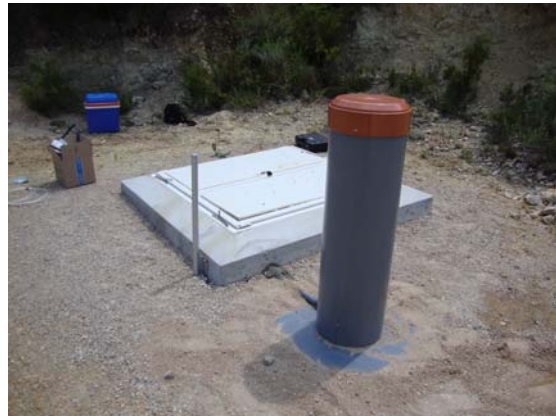
Estació Sísmica Alcanar
