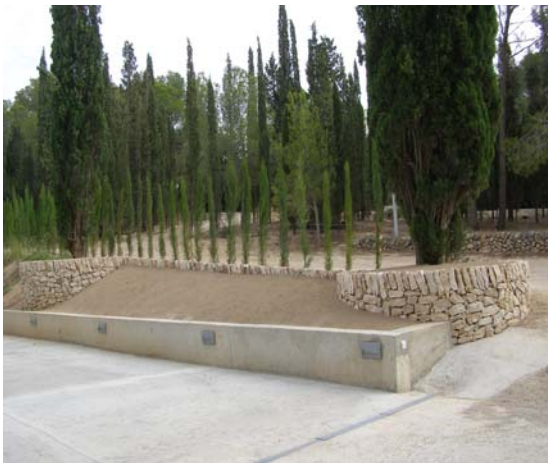
Balones i mur de pedra seca
