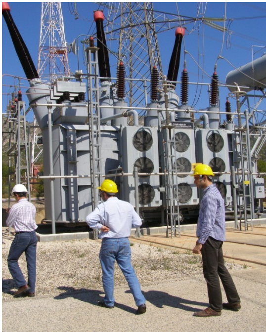
Visita de treball a les instal·lacions de la subestació transformadora d'ENDESA a Vandellòs.
