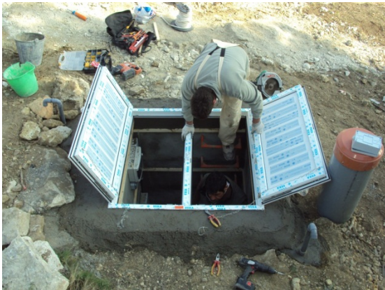
Treballs de construcció de l'habitacle per a l'estació sísmica d'Alcalà de Xivert.
