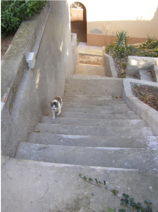
Mur i escales d'accés a la biblioteca
