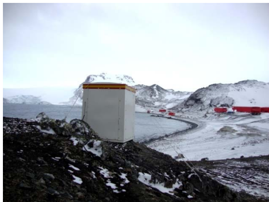
Fig. 4. Detall d'una de les infraestructures que alberga instrumentació de l'OE a la BAE.
