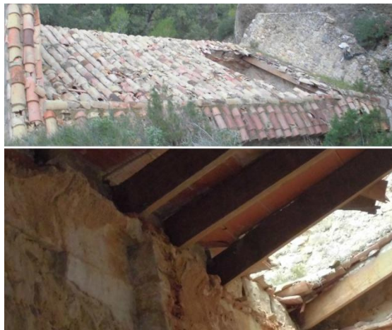
Fig. 10. Detall de l'estat de la teulada de l'Ermita d'Orta de Sant Joan que alberga l'estació sísmica ERTA de l'IGN i l'estació magnètica de l'Observatori.
