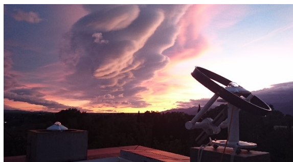
Fig. 15. Detall dels piranòmetres de l'OE per a la mesura de la radiació solar. Detalle de los piranómetros del OE para la medida de la radiación solar.
