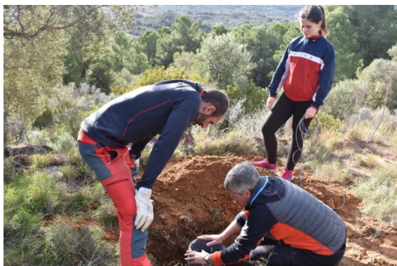
Fig. 8. Instal·lació d'un magnetòmetre al terme municipal de Traiguera (Castelló), sota la línia de 400 kV Vandellòs-La Plana. Instalación de un magnetómetro en el término municipal de Traiguera (Castellón), bajo la línea de 400 kV Vandellòs-La Plana.
