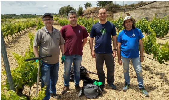
Fig. 13. Instal·lació de sensors d'humitat del sol per cobrir l'activitat del contracte AOSTA amb el COPATE. Instalación de sensores de humedad del suelo para cubrir la actividad del contrato AOSTA con el COPATE.
