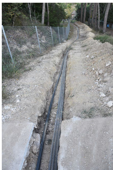
Fig. 10. Detall de l'actuació per a la connexió de la fibra òptica fins el punt d'entrada del proveïdor. Detalle de la actuación para la conexión de la fibra óptica hasta el punto de entrada del proveedor.
