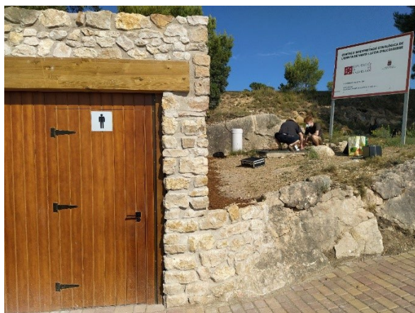
Fig. 18. Detall de la proximitat dels serveis públics construïts al costat de l'estació sísmica d'Alcalà de Xivert. El fet de tenir màquines picant per tal de fer la cimentació tan prop, va aconsellar aturar els geòfons i deixar-los bloquejats en la posició de transport per a que no quedessin afectats per les fortes vibracions. L'estació romandre aturada entre el 19 de maig i el 4 d'agost. Detalle de la proximidad de los servicios públicos construidos al lado de la estación sísmica de Alcalà de Xivert. El hecho de tener máquinas picando para realizar la cimentación tan cerca, aconsejó parar los geófonos y dejarlos bloqueados en posición de transporte para que no quedasen afectados por las fuertes vibraciones. La estación permaneció parada entre el 10 de mayo y el 4 de agosto.
