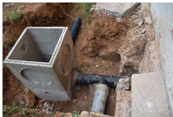
Fig. 11. Detall de l'actuació de connexió de la Residència d'Investigadors al clavegueram municipal. Detalle de la actuación de conexión de la Residencia de Investigadores al alcantarillado municipal.
