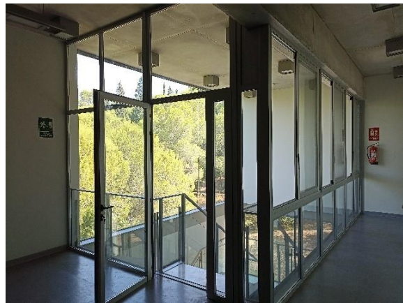
Fig. 17. Detall del tancament amb vidrieres del 2 n pis del pavelló investigadors. Detalle del cierre con vidrieras del 2º piso del pabellón de investigadores.
