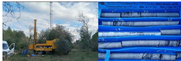
Fig. 2. Detall del sondeig geològic de l'ICGC a l'OE i de mostres extretes al voltant de 250 m de profunditat. Detalle del sondeo geológico del ICGC en el OE y de muestras extraídas alrededor de 250 m de profundidad.
