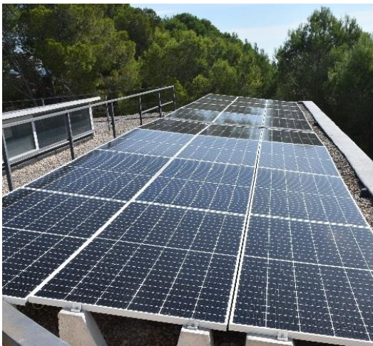
Fig. 18. Detall de les plaques fotovoltaïques a la coberta de l'edifici investigadors. Detalle de las placas fotovoltaicas en la cubierta del edificio de investigadores.
